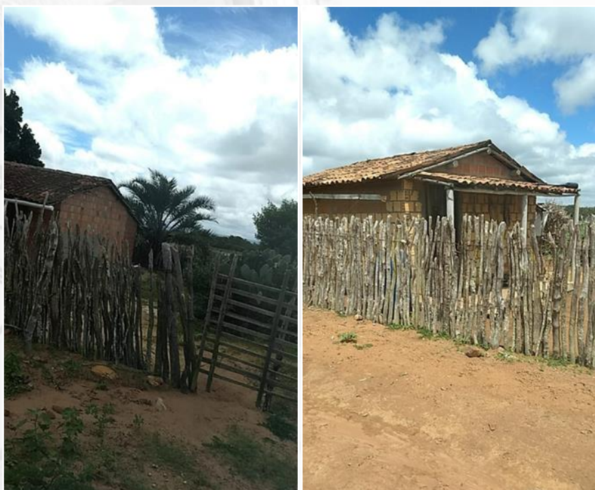
Figura 06 – Residências que serão demolidas no povoado de Tamboril.
