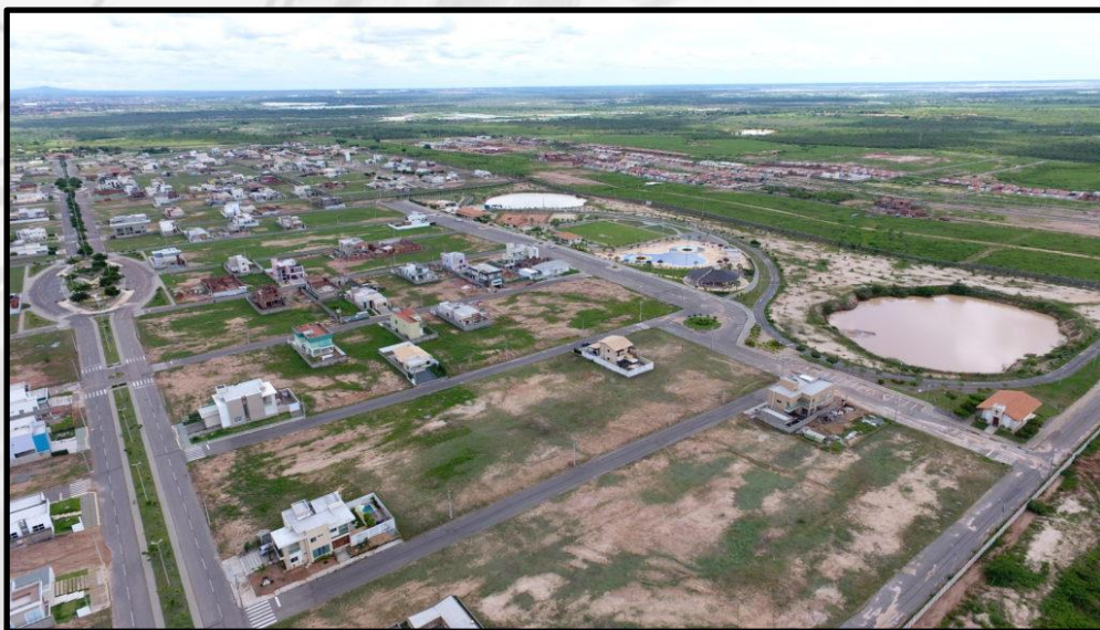
Figura 01 – Recorte de visão aérea do condomínio Ninho Residencial.
