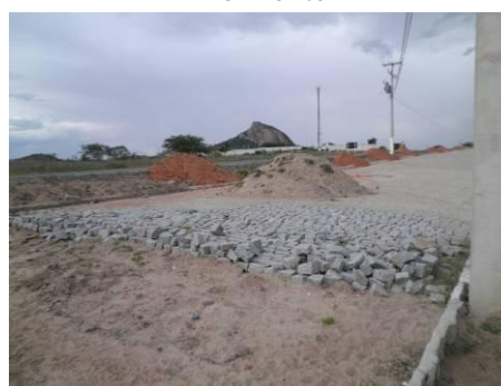
Figura 06: Calçamento do bairro Novo Horizonte
