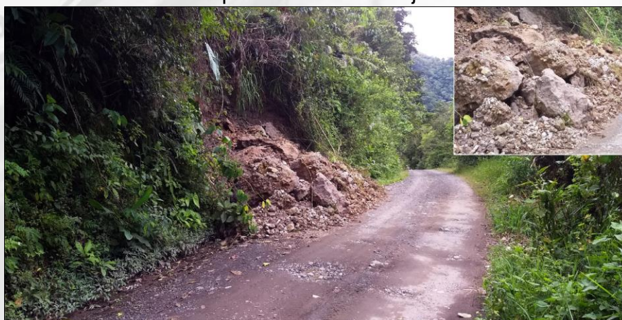
Figura 15 – Desprendimiento en el talud de corte del camino que lleva a la microcuenca superior del río Naranjo.
