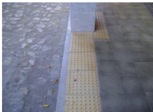
Figuras 03 e 04: Placas de piso tátil de alerta e piso tátil direcional.
