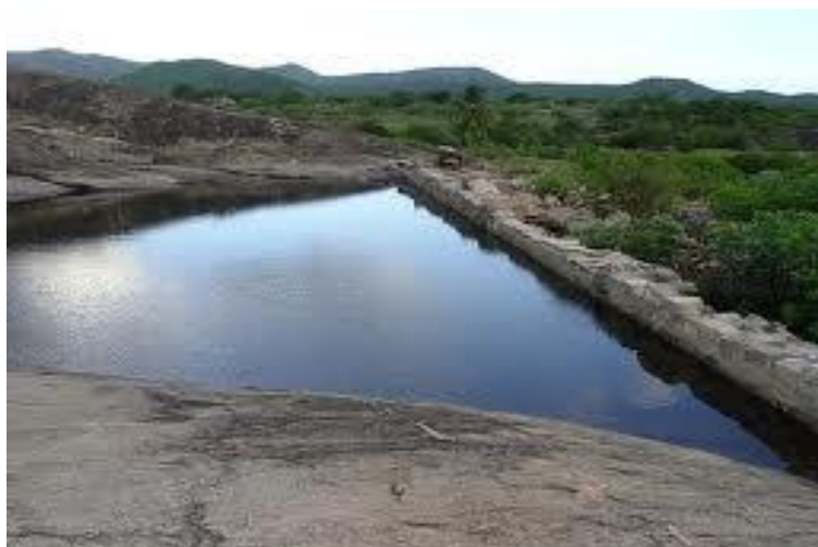
Figura 14: Caldeirão ou tanque de pedra
