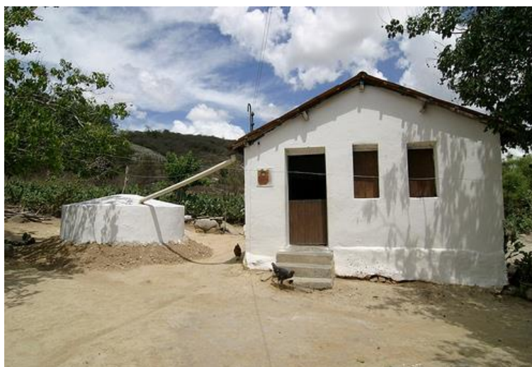
Figura 7: Cisterna rural para captação de água de chuva através do telhado. Fonte: Google imagens.
