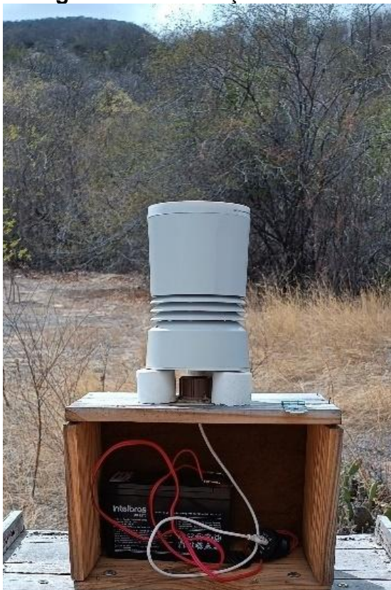
Figura 03 – Instalação do THP3
