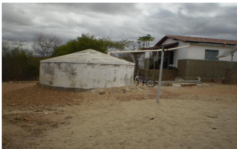
Figura 6: Cisterna de placa construídas em duas residências
