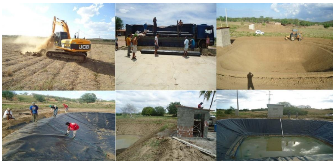
Figura 02 - Processo de escavações, revestimento e construção dos reservatórios e casas de bombas
