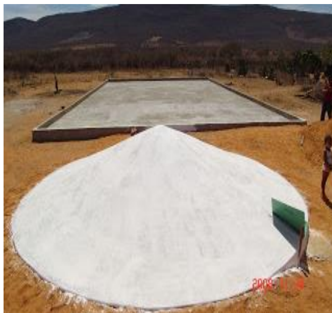
Imagem 02. Cisterna do P1+2
