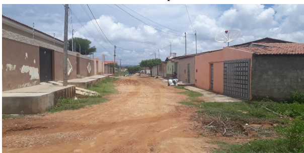
Figura 12 – Bairro Bela Vista – Ausência de infraestrutura pública
