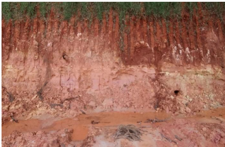
Figura 2 - Vista parcial do talude de corte com os dutos. Foto: Meneguzzo (2021).
