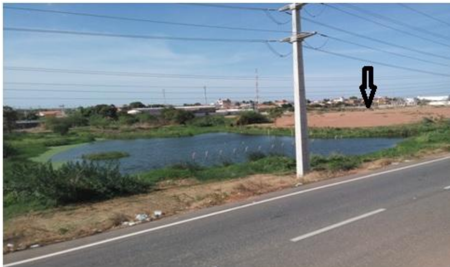
Figura 05: P1 – Nascente do riacho parcialmente aterrada (indicada pela seta).
