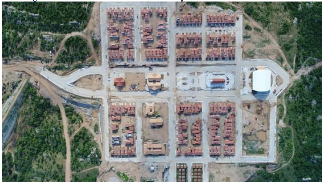
Figura 12: Vista de cima da área de construção da nova Barra de Santana/RN.
