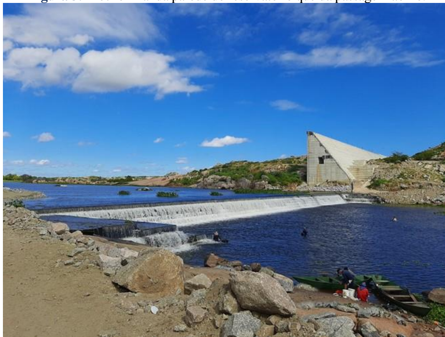
Figura 3: Trecho final da parede do reservatório que dá passagem ao rio.
