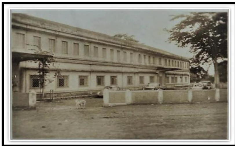
Figura 2: Fachada Central do Instituto Educacional de Dourados, no início da década de 1970
