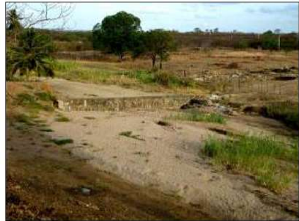
Figura 11: Assoreamento de barragem na comunidade Recanto em decorrência da retirada da mata ciliar. Fonte: O Autor (2013)
