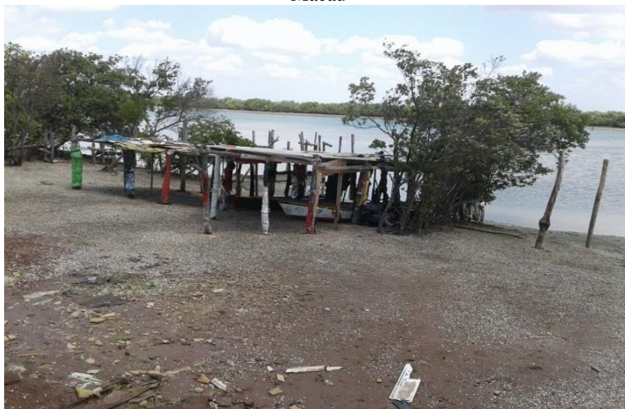
Figura 9: Construção de portos dentro do manguezal na extensão da região central do município de Macau
