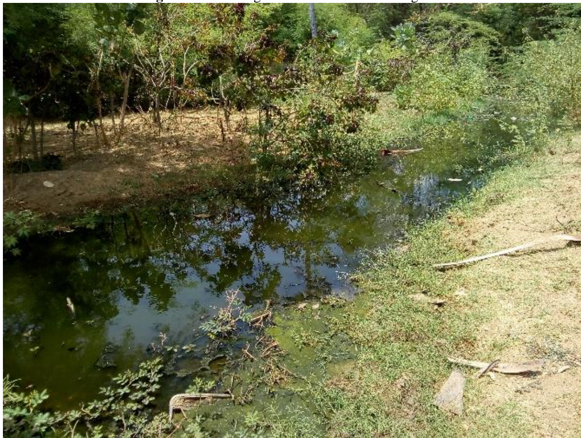
Figura 5: Canal degradado com resíduos de esgotos.
