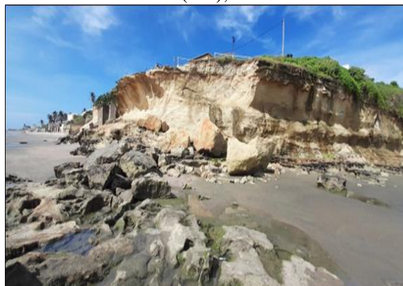
Figura 05: Deterioração da Pedra do Chapéu, Tibau (RN), 2022.
