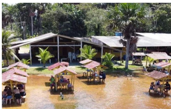
(A) Balneário e Restaurante KM 19 - Mesas Cobertas instaladas no leito do Igarapé Fonte: Elaborado pelo Autor (2023).
